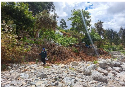
FOTOGRAFIA N°04: Muro seco II en mal estado, colindante a la piscigranja de truchas, ubicada en el margen izquierdo del Río Huancapi con una altura de 1.8m.
