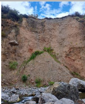
FOTOGRAFIA N°06: Talud con inclinación de 90°, evidenciándose deslizamiento, talud adyacente al centro de Estadio Municipal.
