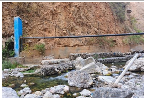
FOTOGRAFIA N°07: Vista de tuberías colapsadas y muro de contención de concreto + conglomerado, arrasados por las máximas avenidas del Río Huancapi.
