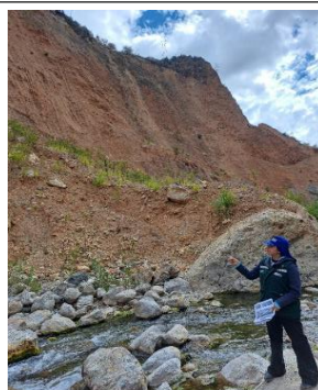
FOTOGRAFIA N°10: Talud con inclinación de 90° y una altura aproximada de 60 m, evidenciándose deslizamiento, talud adyacente al I.E.S "Basilio Auqui".
